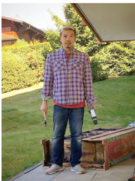
Déconstruction d'une armoire abandonnée trouvée dans le village
